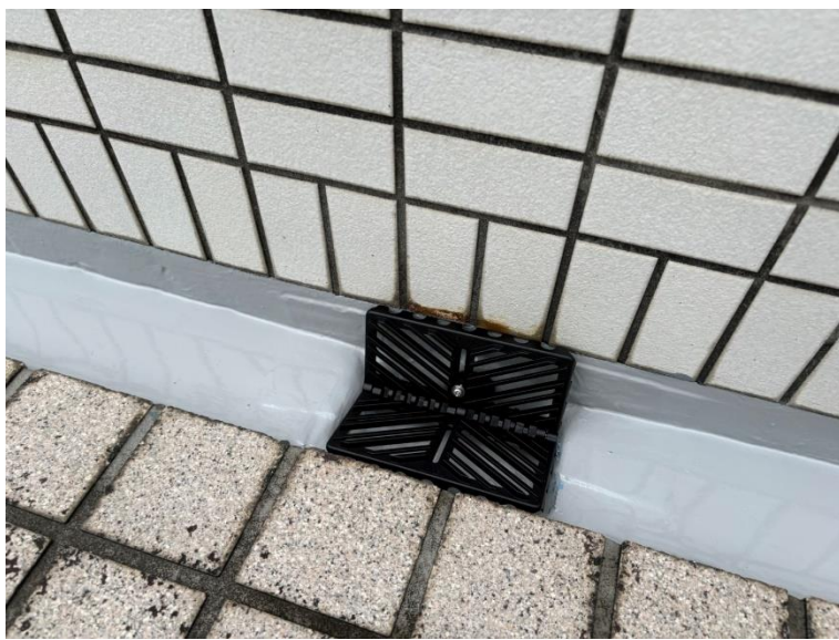
漏水補修工事(5階廊下東側)
