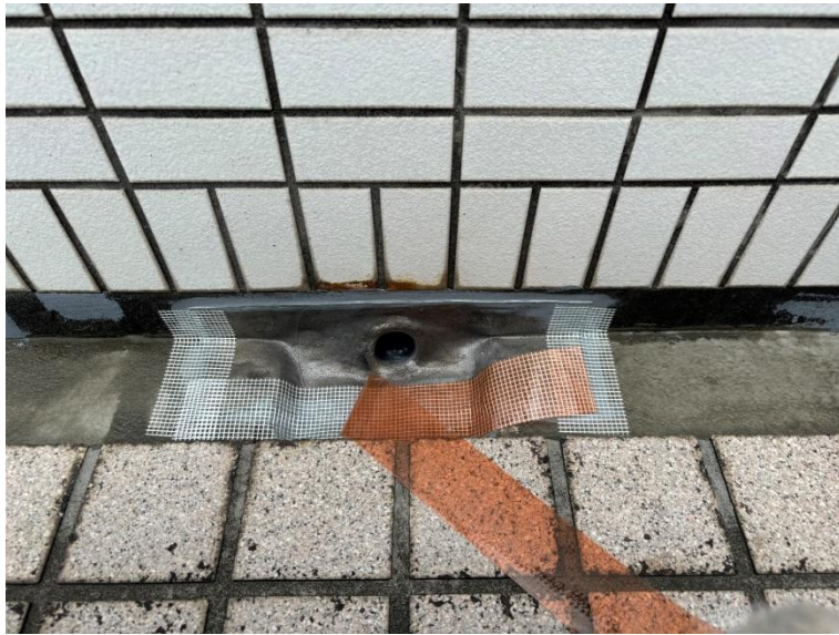
漏水補修工事(5階廊下東側)
