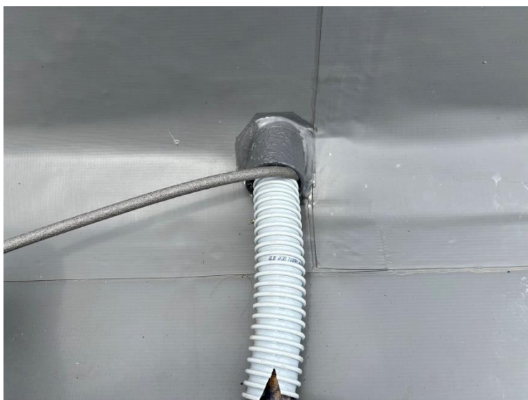
屋上側 ドレインホース廻り バックアップ材挿入状況
