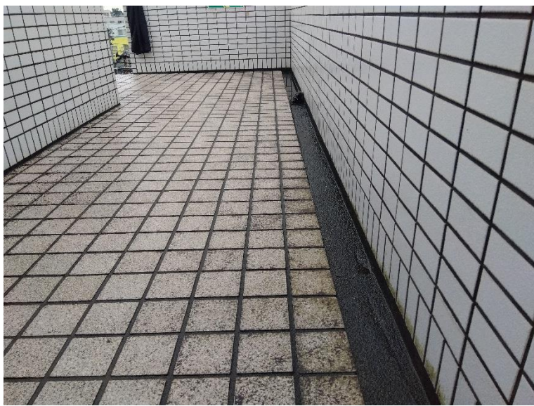
漏水補修工事(5階廊下東側)
