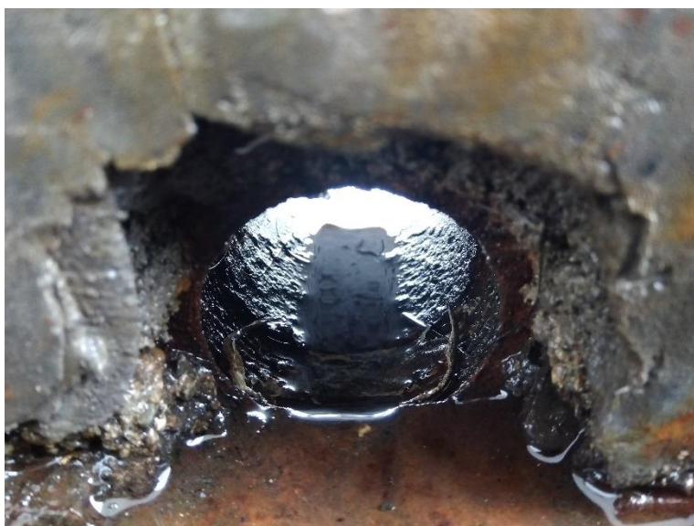
同 上(ドレン接続状況)
